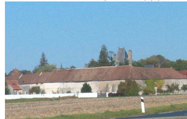
Belle vue sur le comble en fer de hache (Monument historique) à préserver
